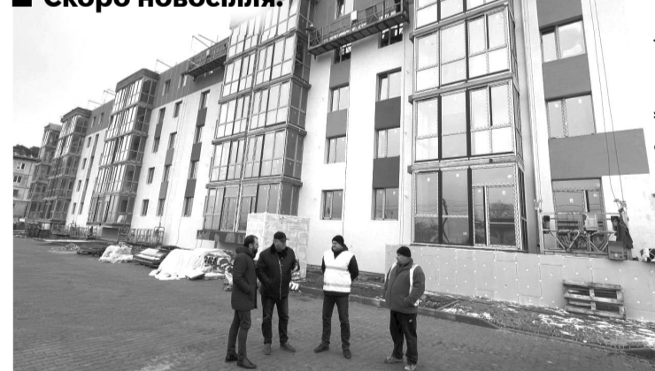
Будівництво тут розпочалося навесні 2024 року.
