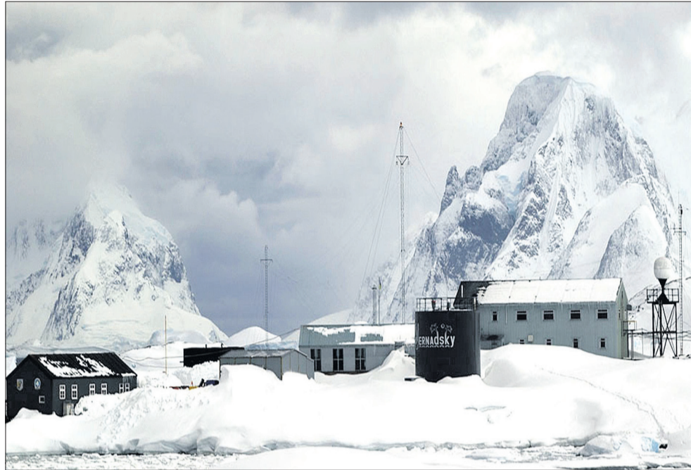
Збудована в минулому столітті британцями полярна станція і нині служить науці.
