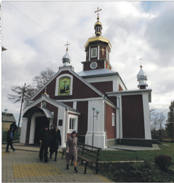
Такою ошатною стала культова споруда після ремонту.
