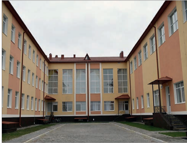
Приміщення сільського навчального закладу збудоване за європейськими стандартами.
