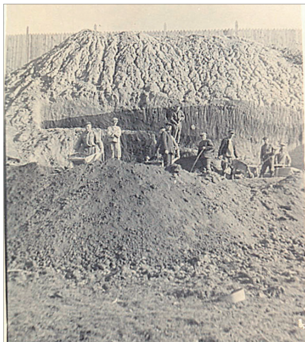
Під час будівництва електростанції на вул. Залізничній у Луцьку. 50-ті роки минулого століття.
