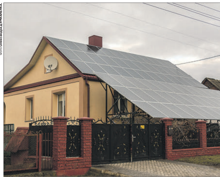
Рационалізатор установив 108 модульних секцій.
