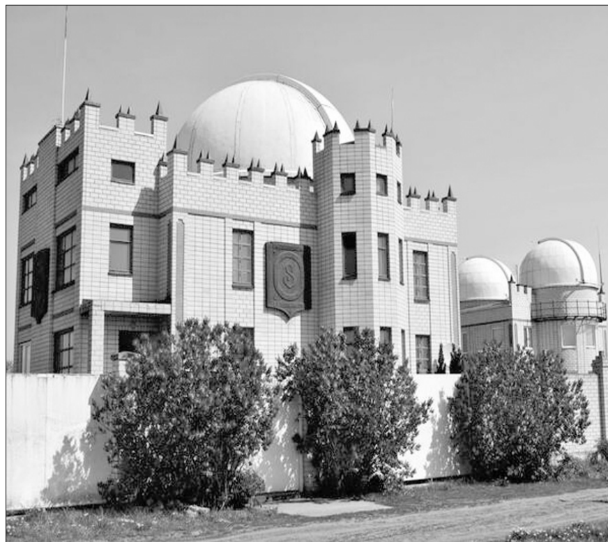
Уже майже 20 літ ентузіасти в цій будівлі вивчають небесні тіла.
