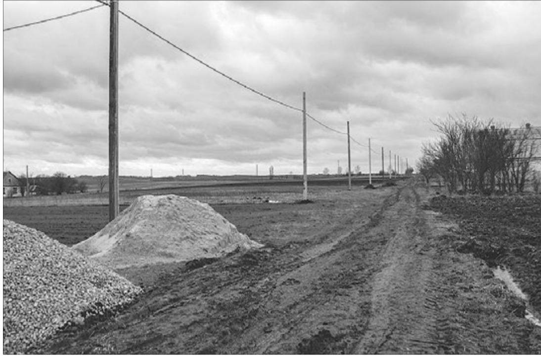
Видно, що роботи з прокладання електролінії завершилися недавно.
