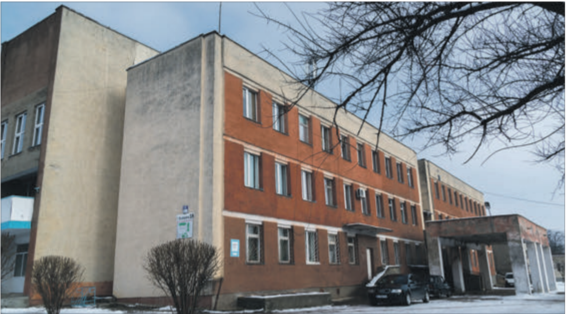
Громіздке приміщення Володимир-Волинської станції переливання крові потребує ремонту.
