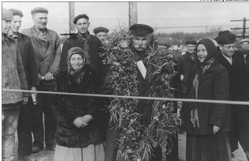
Відкриття залізобетонного мосту в м. Новомиргороді на Кіровоградщині через річку Велика Вись. 20 жовтня 1962 рік. Цей міст служить ще й досі.
