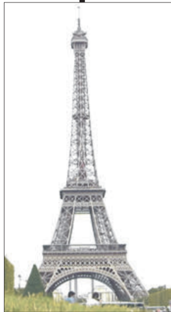
Конструкція Ейфелевої вежі важить 7 300 тонн, ширина основи — 125 метрів, висота (з антеною) — 324 метри.
