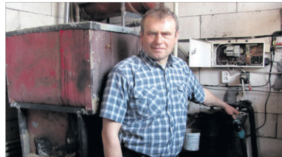
Володимир Орищук обладнав старий котел спеціальним бункером, у який засипає тирсу.
