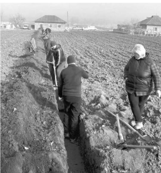
«Гляньте, скільки чоловіків копали рів під трубу й електрокабель!».
